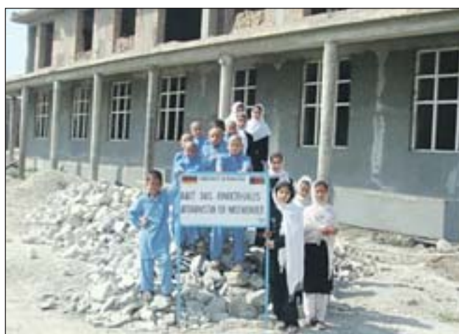
DER ROHBAU STEHT SCHON: Im nächsten Frühjahr soll dieses Kinderhaus Afghanistan, ein Waisenhaus mit Schule, fertig sein.
